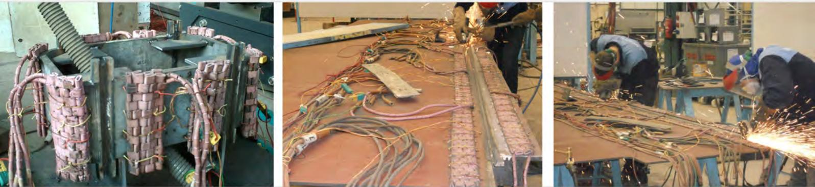
Si le chantier le demande METALMECANICAS HERJIMAR dispose d'une équipe spécialisée en application de traitements thermiques lors des processus de soudure, ainsi que le suivi et le control via des graphiques qui permettent de donner de la traçabilité aux processus requis.
